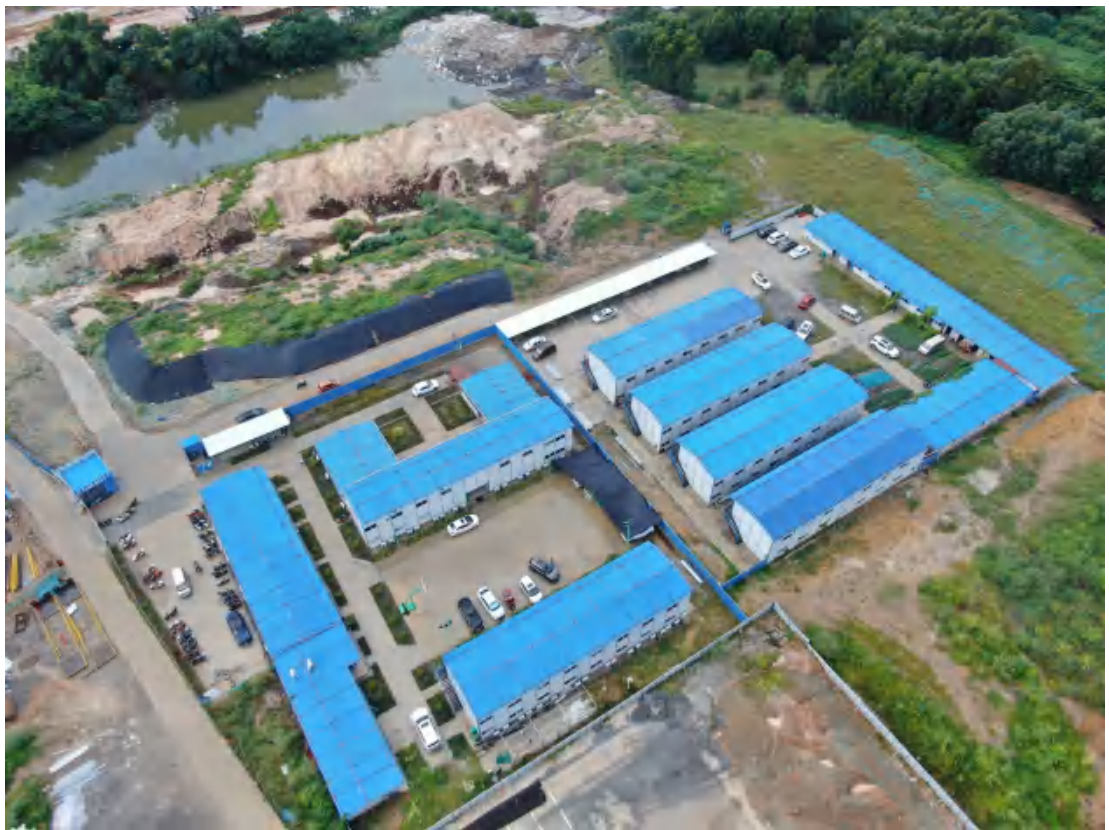
图4 施工生产生活区
