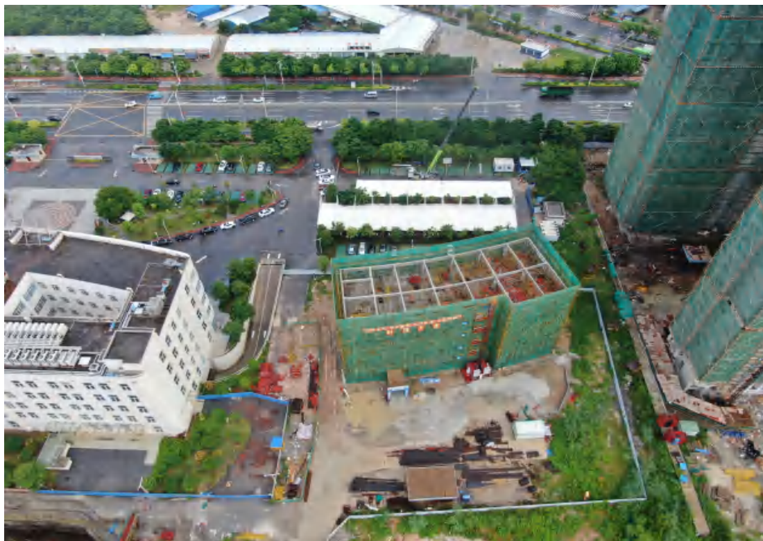
图2 后勤保障楼现状
